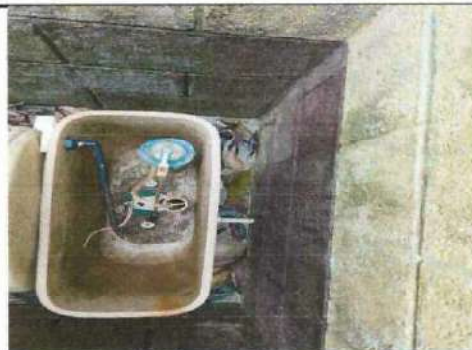
Foto 6: Se observa que es necesario colocarle flote.
