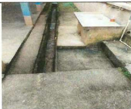
Foto 5: Se observa que es necesario colocarle rejillas para evitar accidentes.
